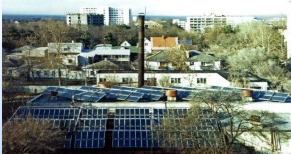
Anapa: Thermische Solaranlage des städtischen Krankenhauses Die Fläche der Solarkollektoren beträgt 413 m 2
