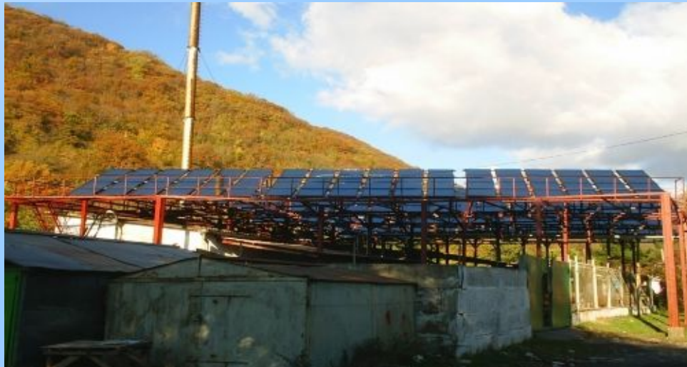
Anapa: Thermische Solaranlage des städtischen Krankenhauses Die Fläche der Solarkollektoren beträgt 413 m 2
